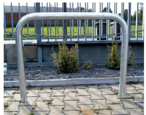
Die drehbare Wegesperre sitzt auf der einen Seite lose und auf der anderen Seite fest in Bodenhülsen. Durch das Öffnen des vorhandenen Dreikantschlusses lässt sich die Wegesperre am losen Bodenhüsenteil drehen.
